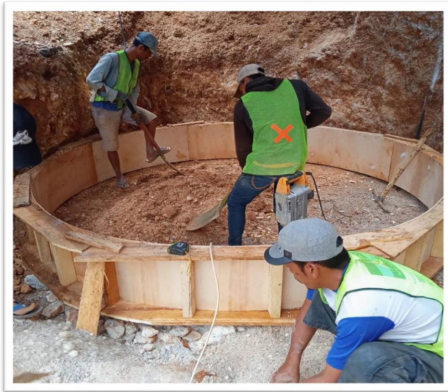
Gambar L3 : Pembuatan Bekisting Pondasi Sumuran
