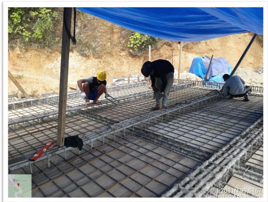
Gambar L8 : Pembesian Plat Lantai
