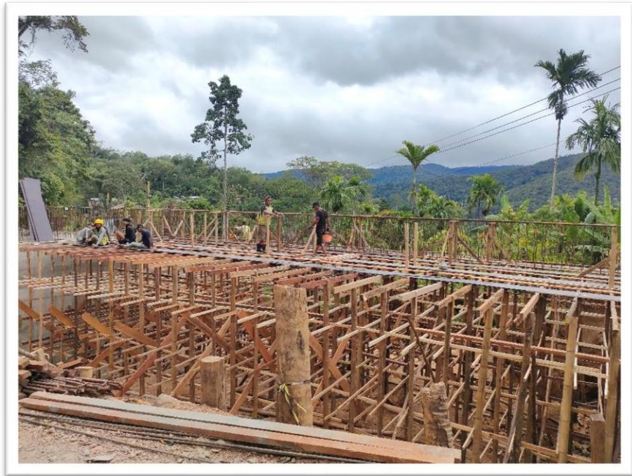
Gambar L7 : Pembesian Balok
