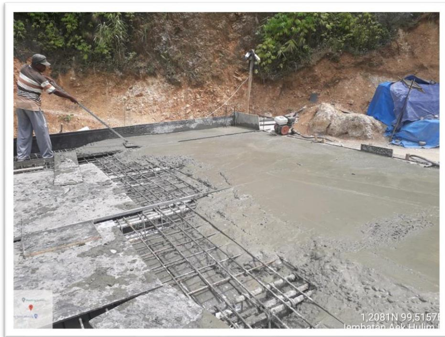
Gambar L9 : Pengecoran Plat Lantai
