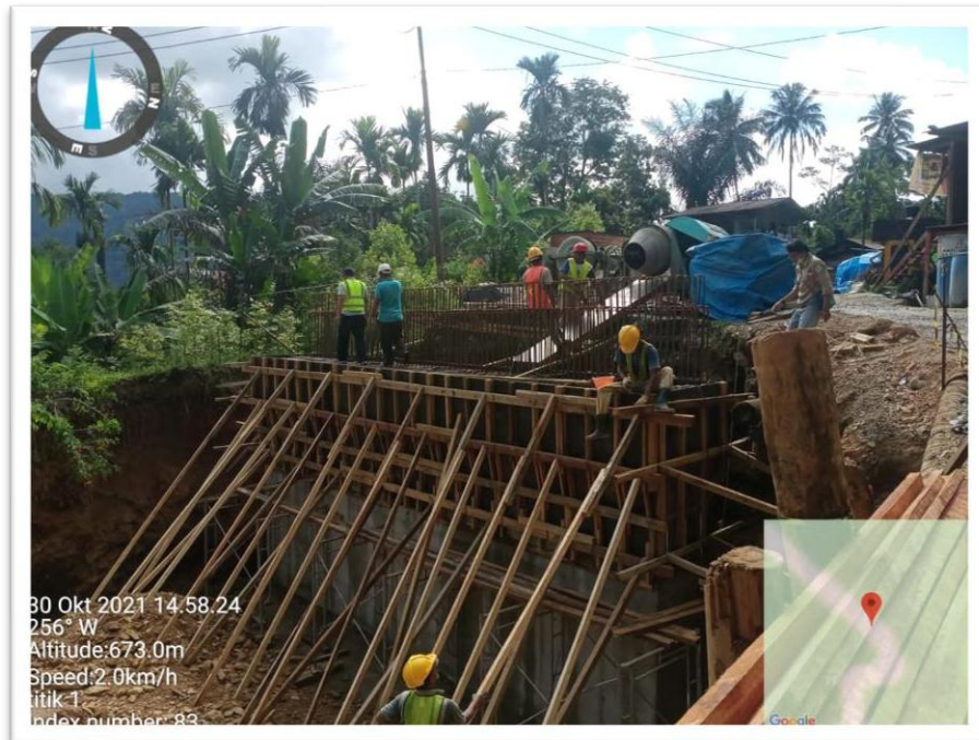
Gambar L6 : Pengecoraan Body Abutment
