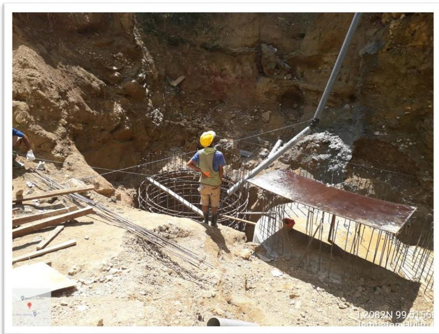
Gambar L4 : Pengecoran Pondasi Sumuran
