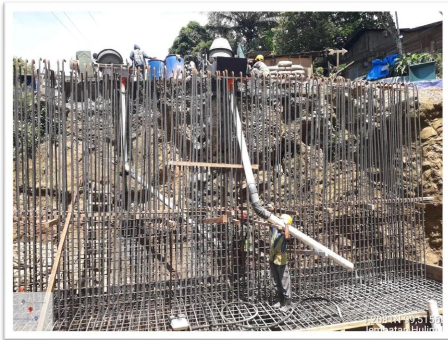
Gambar L5 : Pengecoran Pilecap
