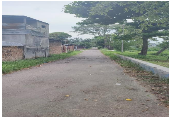
Gambar 3.5: Lokasi Rentan Banjir Dijalan Gereja
