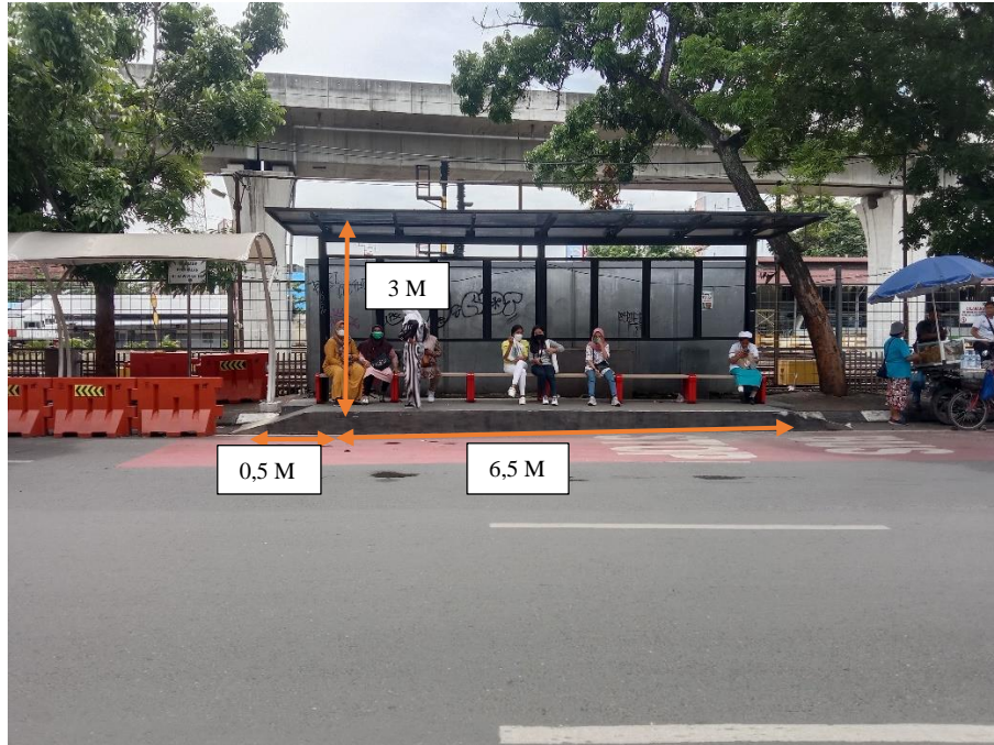
Gambar 4.3: Dimensi halte permanen dengan menggunakan rump
