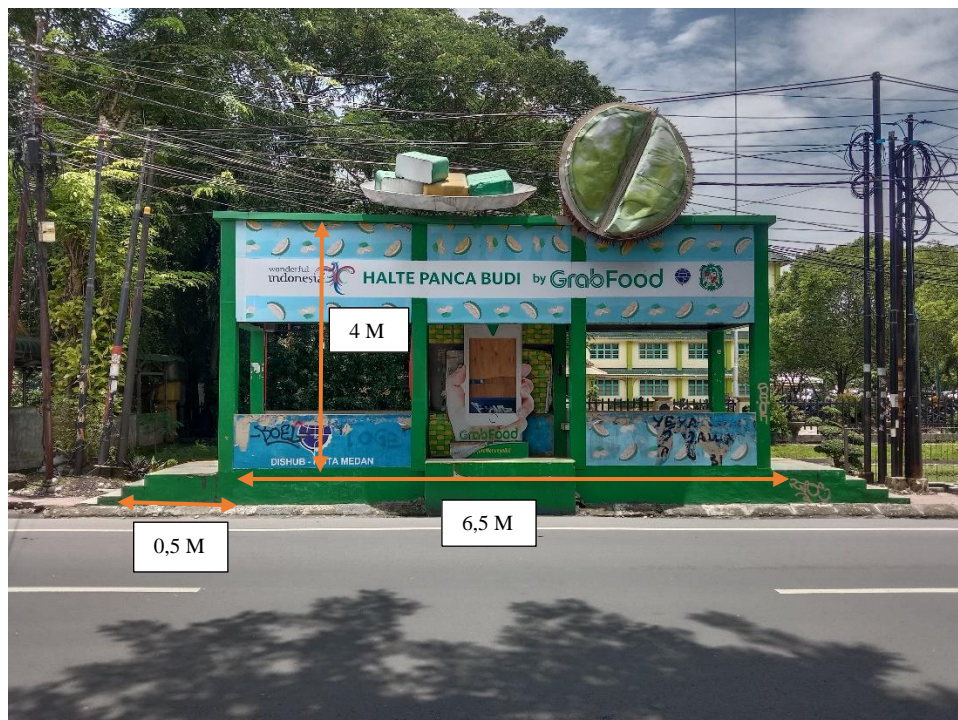
Gambar 4.2: Dimensi halte permanen tanpa menggunakan rump
