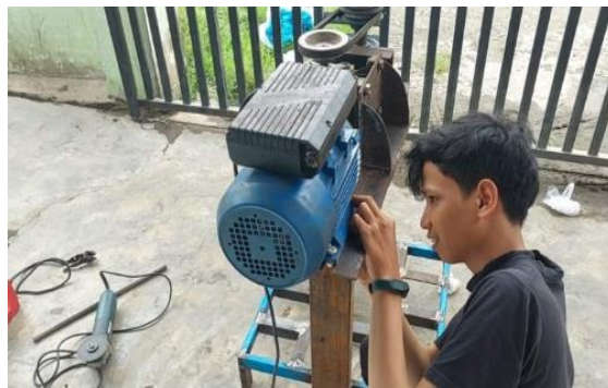
Gambar 4.5 Proses pemasangan motor AC 1 phasa
