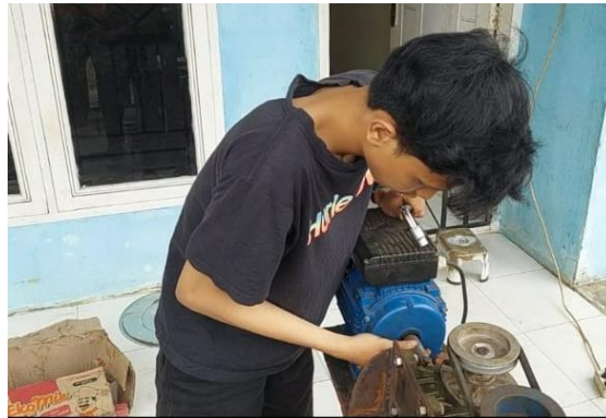
Gambar 4.4 Proses pemasangan motor AC 1 phase ke pully gearbox
