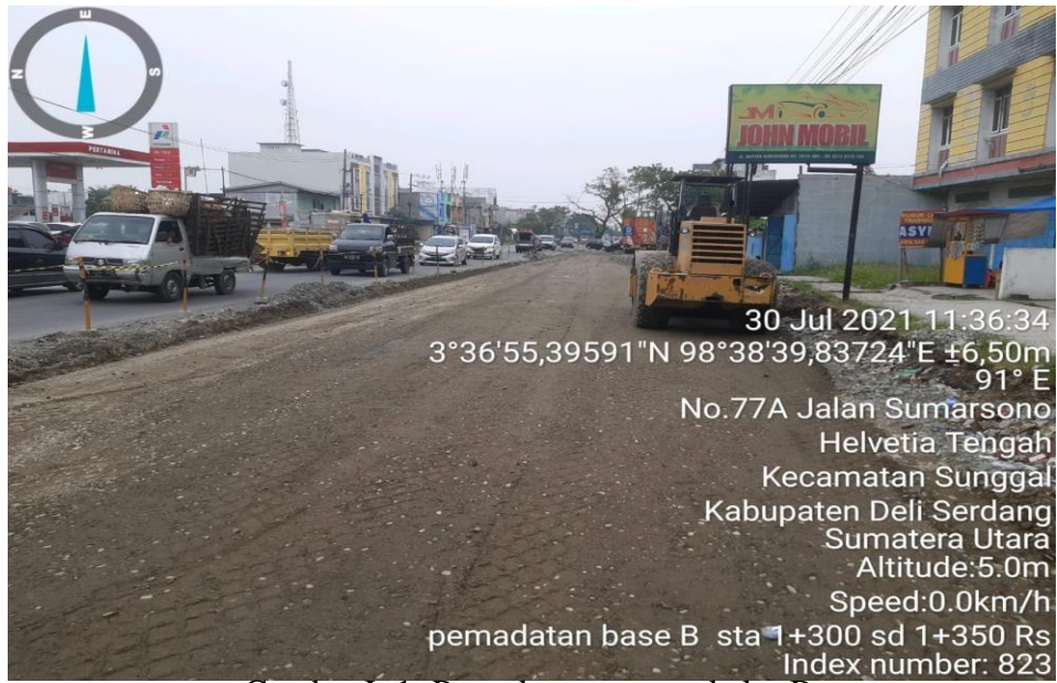
Gambar L.1: Pemadatan agregat kelas B
