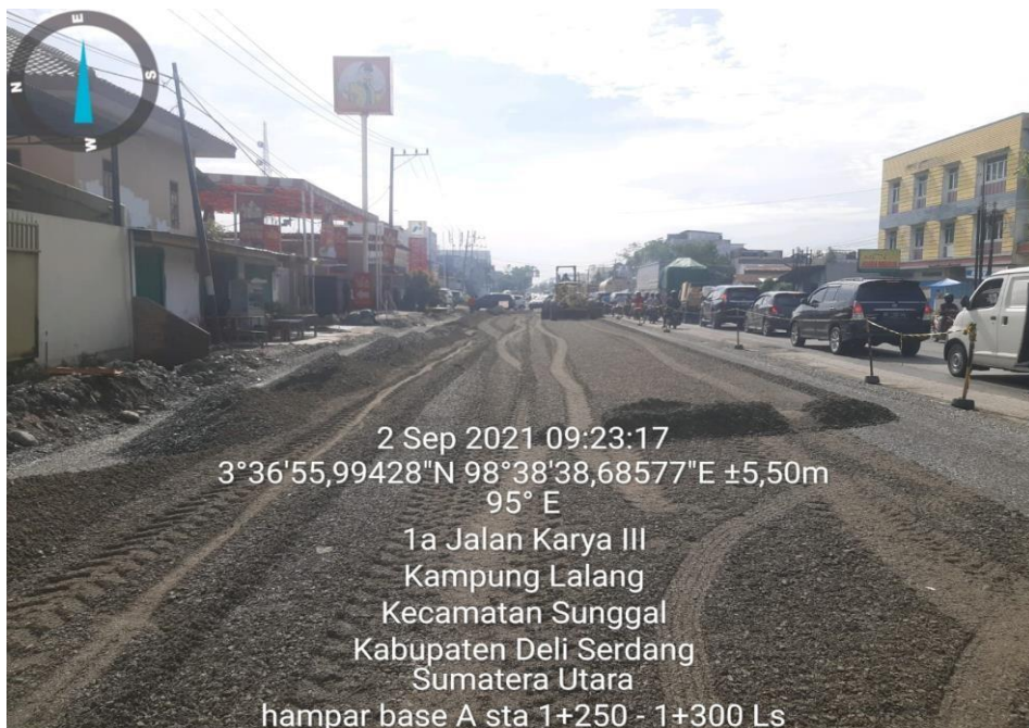
Gambar L.2: Pemadatan agregat kelas A
