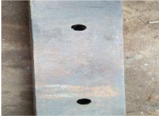
Gambar 4.8 Baja UNP Sebagai Baut Penggunci Bearing
