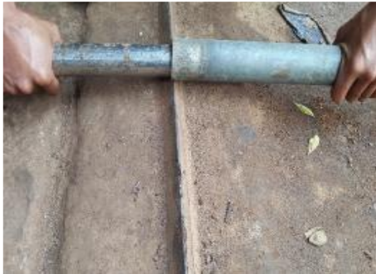
Gambar 4.18 Penggabungan Pipa Besi dan Poros
