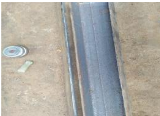
Gambar 4.7 Baja UNP Tulang Rangka Bagian Atas dan Bawah
