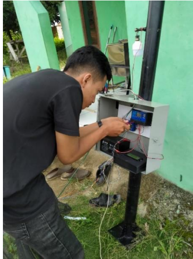
Gambar 4. Proses Pemasangan Sistem
