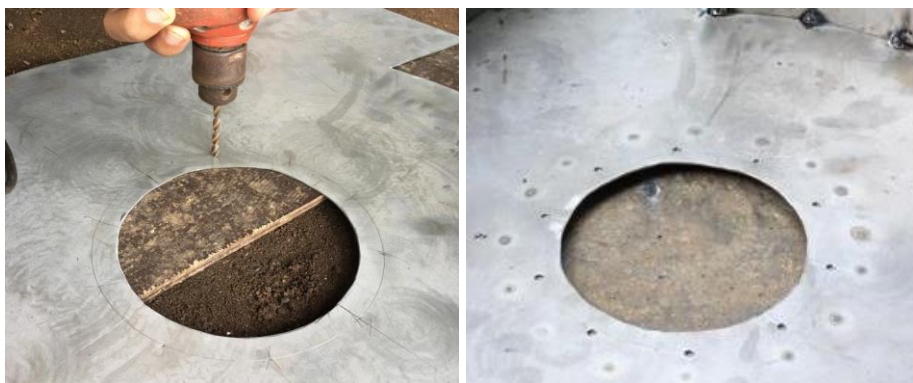
Gambar 4. 4 Proses pengeboran rumah turbin
