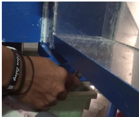
Gambar 4. 24 Pemasangan dudukan aliran turbin
