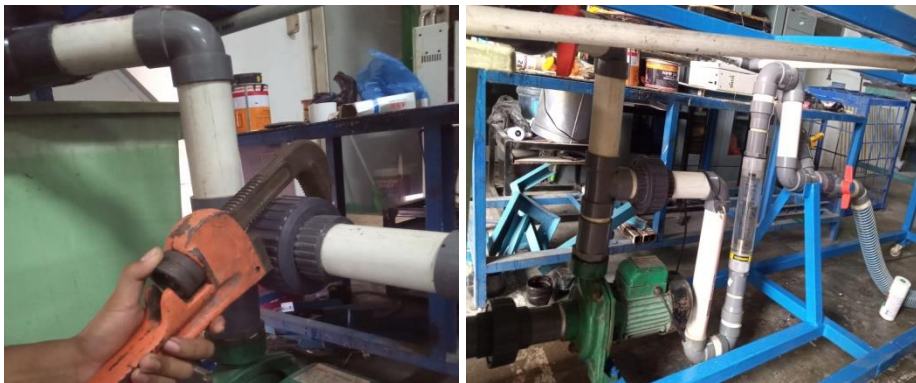
Gambar 4. 26 Pemasangan pipa pengalir
