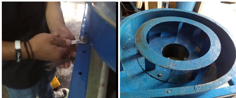
Gambar 4. 22 Pemasangan Rumah Turbin
