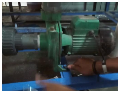
Gambar 4. 27 Pemasangan mesin pompa sentri pugal.
