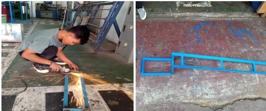
Gambar 4. 18 Proses penggerindaan dudukan aliran air
