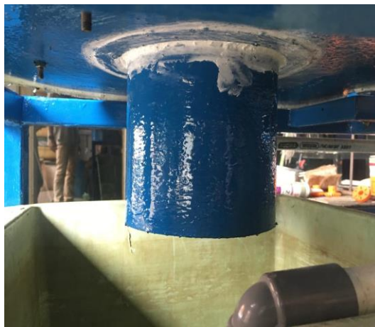
Gambar 4.18 Lubang Pipa Sudah Disatukan Dengan Las
