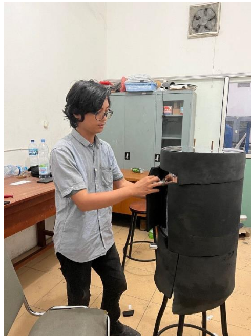
Gambar 3.39 Pelapisan insuflex ke tangki horizontal
