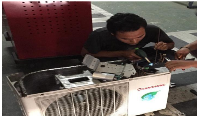
Gambar 4.18 Pemasangan Sensor Pada Jalur Refrigerant
