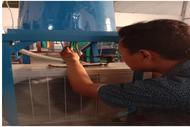
Gambar 4.24 Penyambungan Pipa Tembaga
