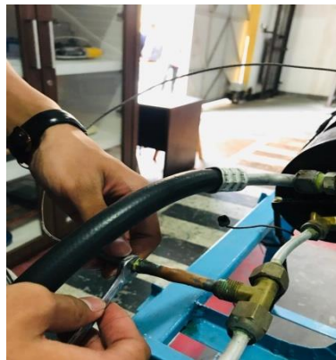
Gambar 4.10. Pemasangan sensor dari driyer ke evaporator
