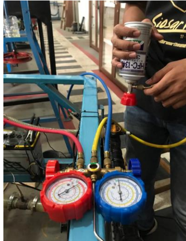
Gambar 4.16. Pengisian freon pada selang tekanan tinggi
