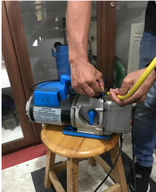
Gambar 4.14. Menyiapkan pompa vakum
