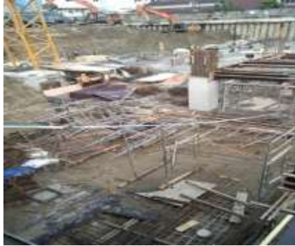
Gambar 3.3: Persiapan Pemasangan Besi
