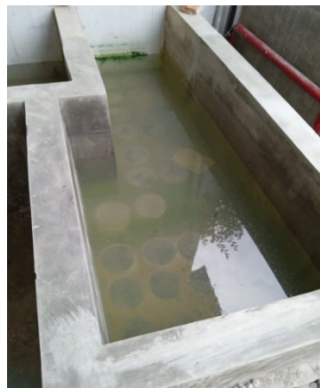
Gambar 3.5: perawatan beton.
