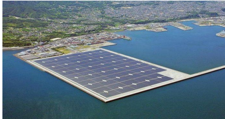
Gambar 2.2.4 Pembangkit Listrik Tenaga Surya
