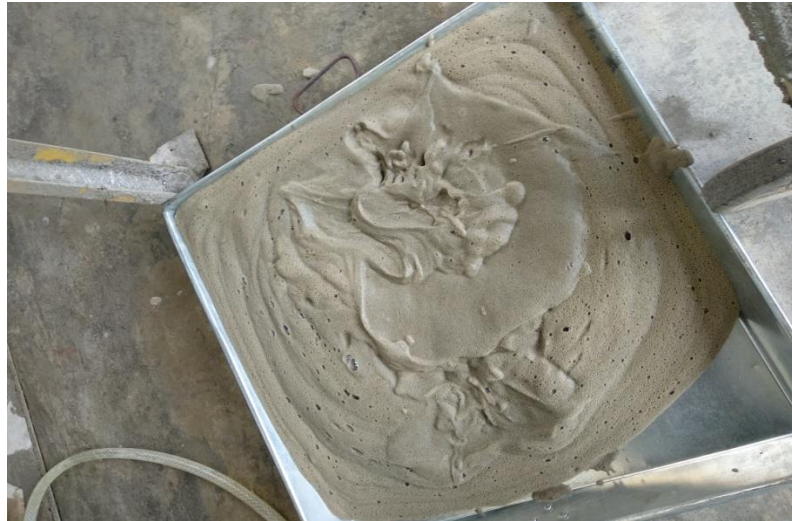
Gambar 3.31: Beton segar setelah di mixer mesin pengaduk.
