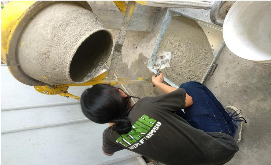
Gambar 3.30: pengeluaran beton segar yang telah di campur di dalam molen.
