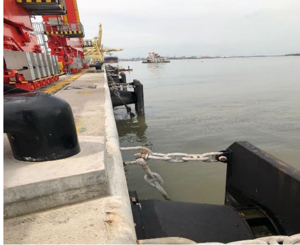
Gambar 4.2: Ilustrasi jarak antar fender
