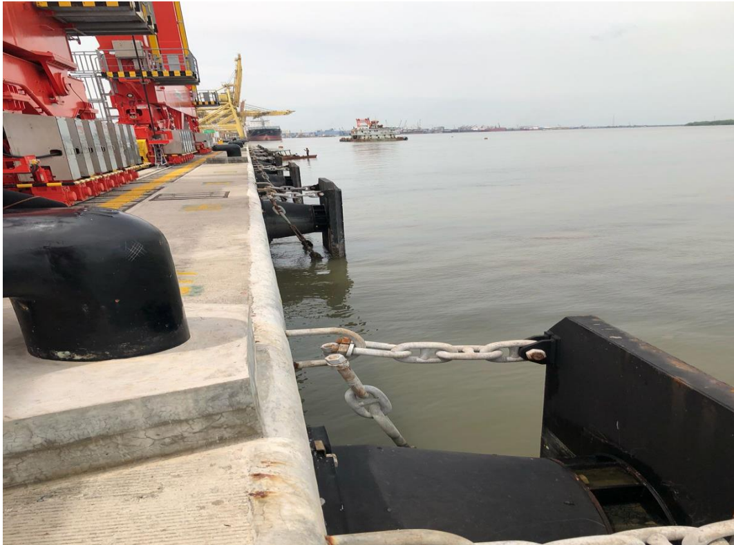
Gambar 3: jarak antar fender yang ada di pelabuhan peti kemas Belawan.
