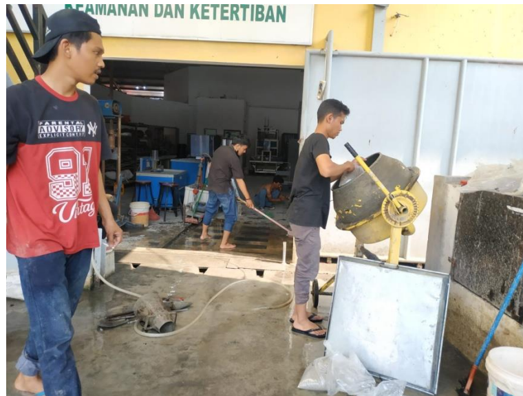
Lampiran 27: Proses pembuatan adukan beton.
