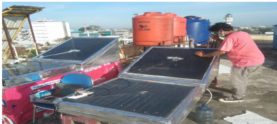
Gambar 4.2 Proses instalasi alat desalinasi
