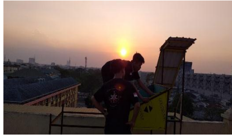
Tahap Pemasangan kaca Pada Evaporator
