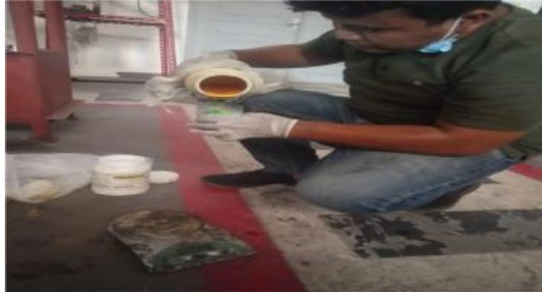
Gambar 3.21. Mencampur resin epoxy dengan hardener
