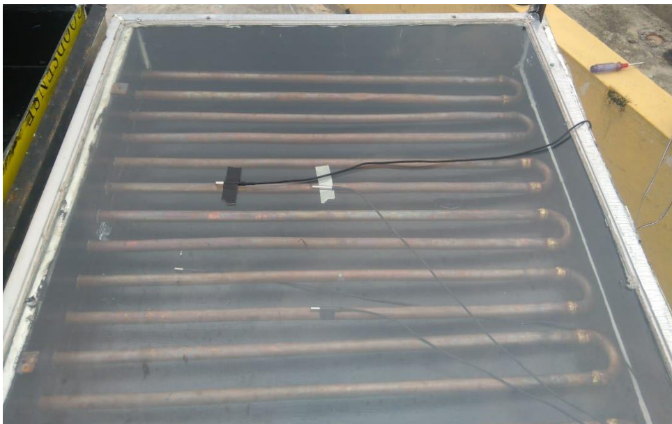
Pemasangan thermokopel pada bagian-bagian kolektor serta melakukan pengujian
