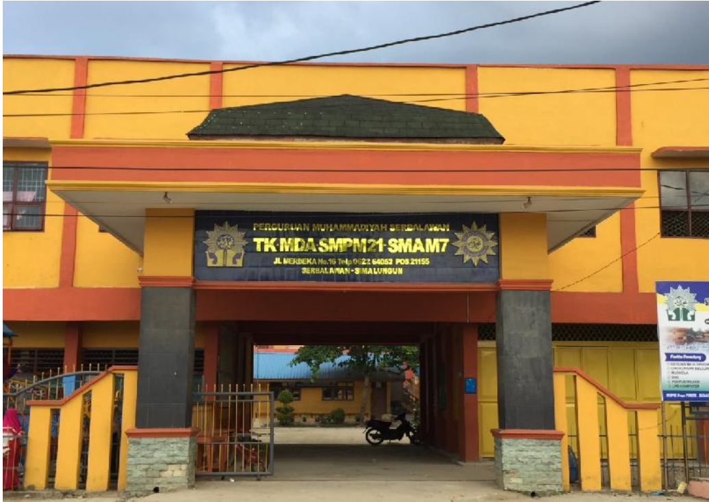
Gambar 9. Gedung SMP Muhammadiyah-21 Dolok Batu Nanggar
