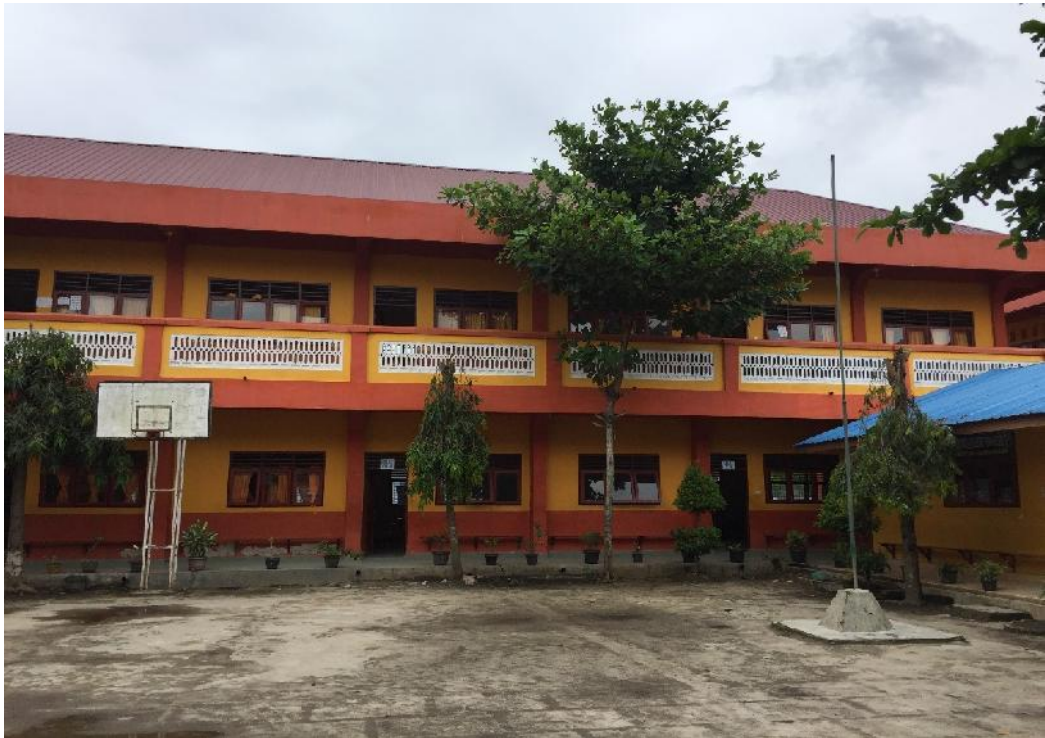
Gambar 12. Gedung SMP Muhammadiyah-21 Dolok Batu Nanggar
