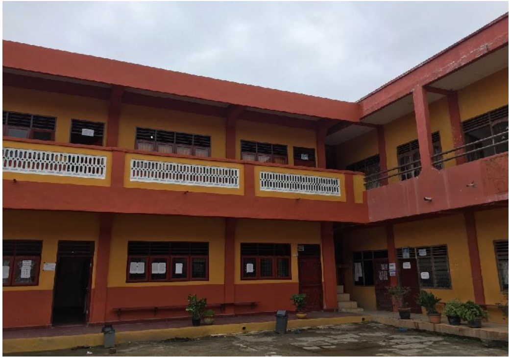
Gambar 11. Gedung SMP Muhammadiyah-21 Dolok Batu Nanggar
