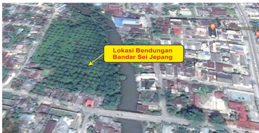
a. Lokasi Pembangunan Bendungan Bandar Sei Jepang Kota Tanjungbalai
