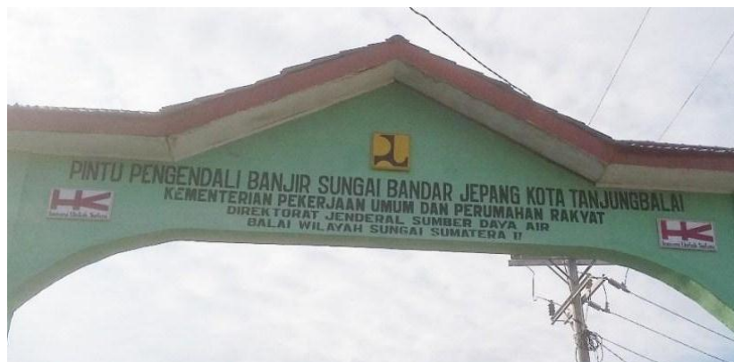
b. Bendungan Bandar Sei Jepang Kota Tanjungbalai
