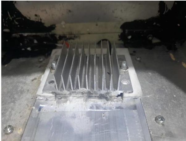
Gambar 3. Proses pemasangan Heatsink, Ke Kotak Cool box
