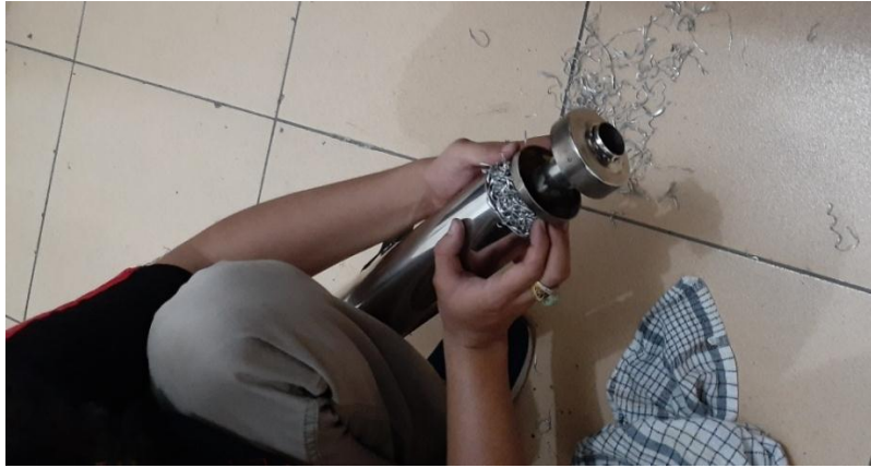
Gambar 4.14. Proses pemasangan sponge steel
