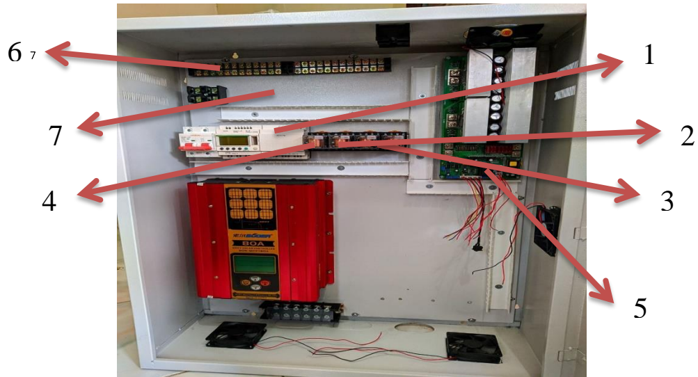
Gambar 4.1 Rancangan ATS smart relay Zelio
