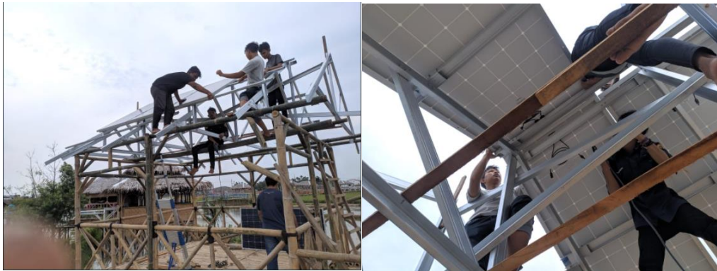
Gambar 4. Pemasangan Panel Surya
