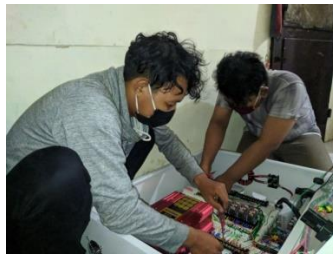
Gambar 3.17 Gambar Proses Pengkabelan
