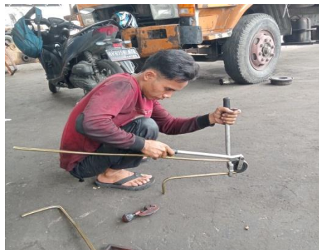
Gambar 4.2. Proses pembengkokan selang penghubung
