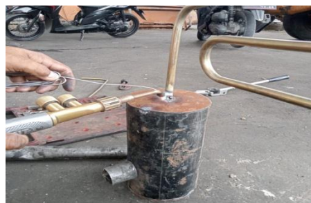
Gambar 4.13. Proses pengelasan selang penghubung
