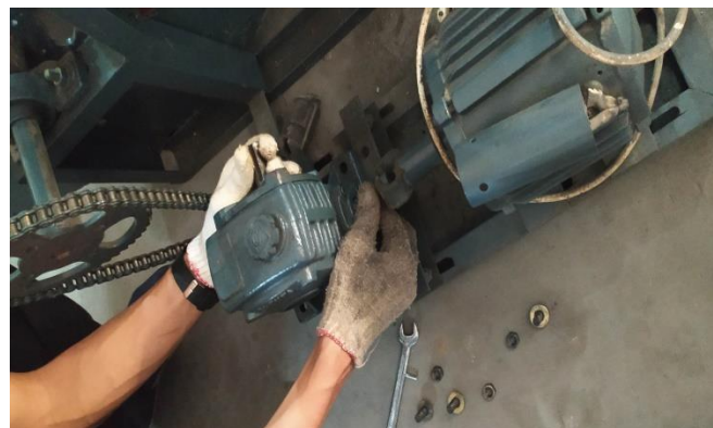
Gambar.3.11.Melepaskan gear box dari bodi fruit elevator.
