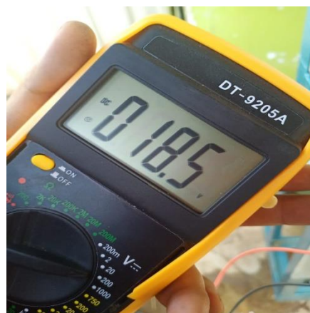
Gambar pengukuran tegangan menggunakan alat ukur multimeter
