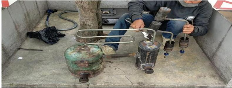
Gambar langkah percobaan 2. Memasang mur nepel kondensator.
