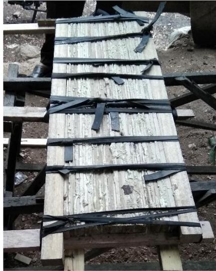
Gambar 3.26 Proses pengikatan bilah-bilah bambu
