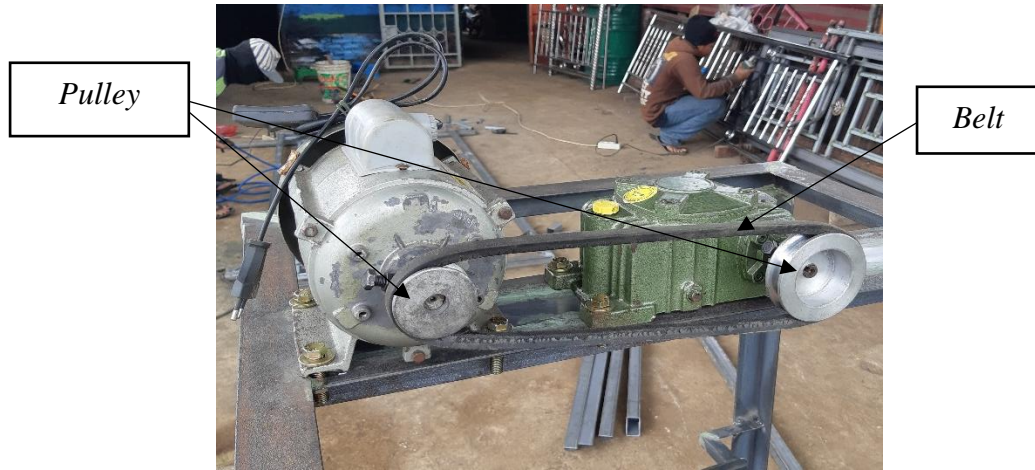
Gambar 4. 14. Memasang Pulley dan Belt
