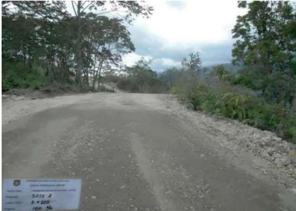
Gambar L3. Lapisan agregat kelas A
