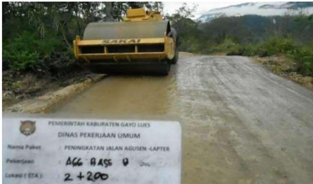
Gambar L1: Pemadatan agregat kelas B.
