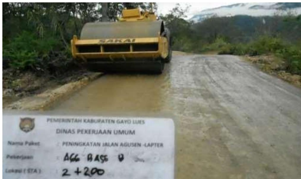
Gambar L1: Pemadatan agregat kelas B.
