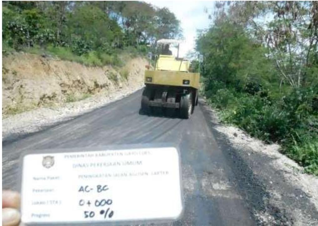
Gambar L7: Pemadatan laston resap pengikat (aspal cair)
