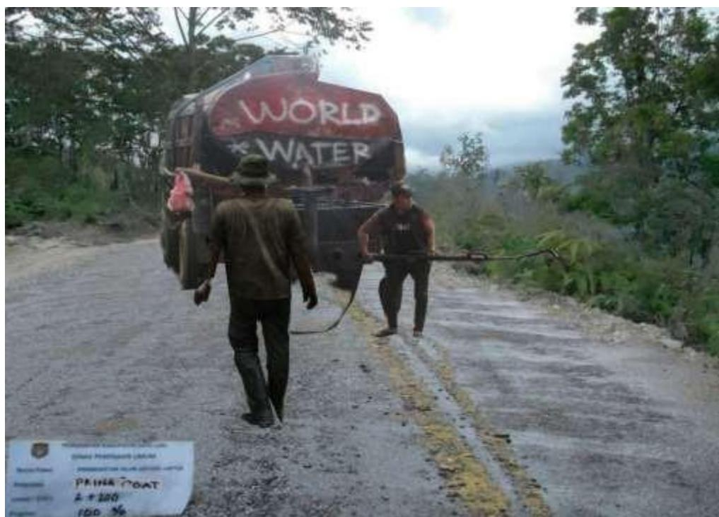
Gambar L4: Lapisan resap pengikat-aspal cair
