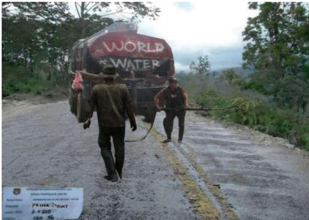
Gambar L4: Lapisan resap pengikat-aspal cair
