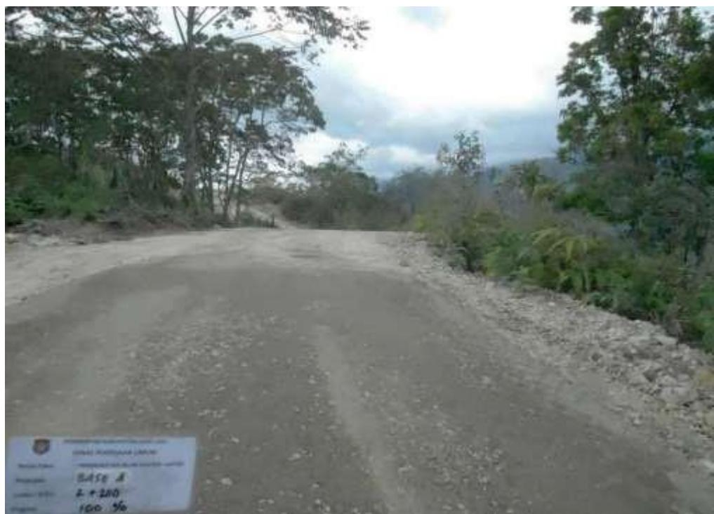
Gambar L3. Lapisan agregat kelas A
