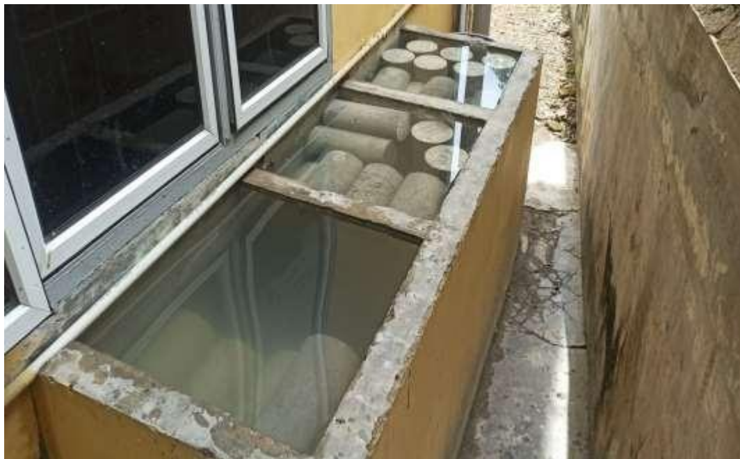
Gambar L.6: Melakukan Perawatan Beton ( Curing ) dengan Cara Merendam Beton
