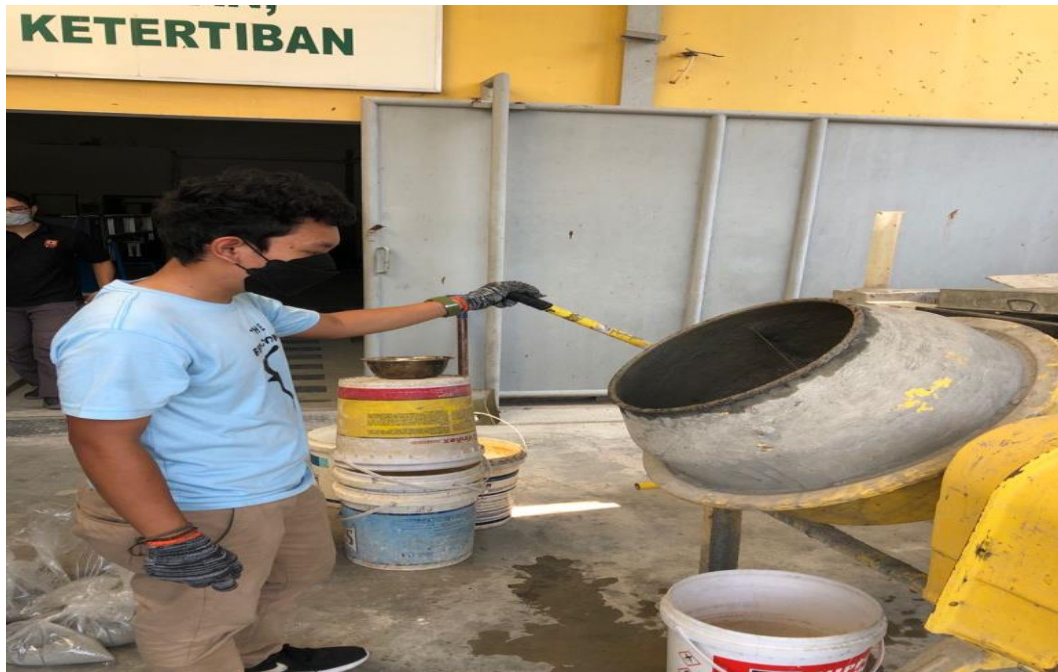
Gambar L.1: Mencampurkan Semua Bahan ke Dalam Mixer
