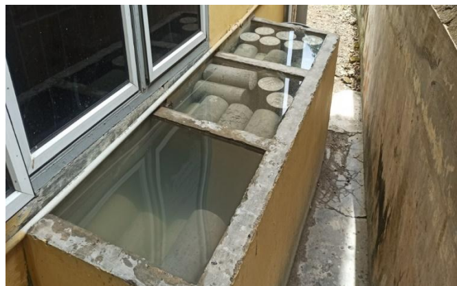
Gambar L.6: Melakukan Perawatan Beton ( Curing ) dengan Cara Merendam Beton
