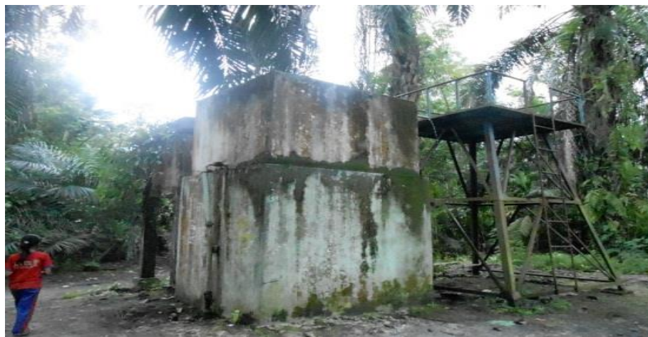
Lampiran 8 : Menara Air Existing IKK Kotarih
