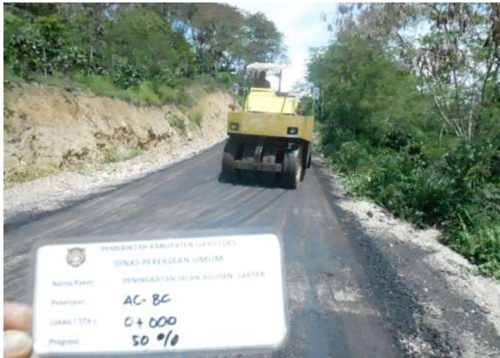
Gambar L7: Pemasangan laston resap pengikat (aspal cair)
