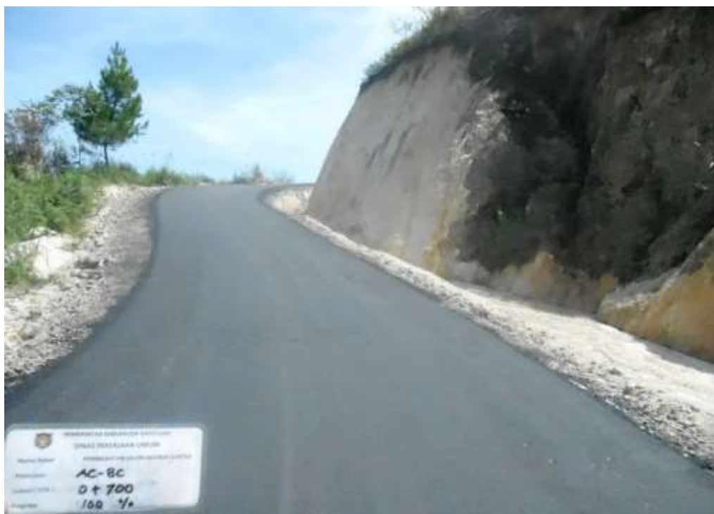
Gambar L8: Lapisan perkerasan AC-BC
