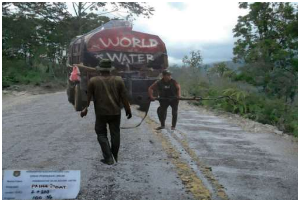
Gambar L4: Lapisan resap pengikat-aspalcair
