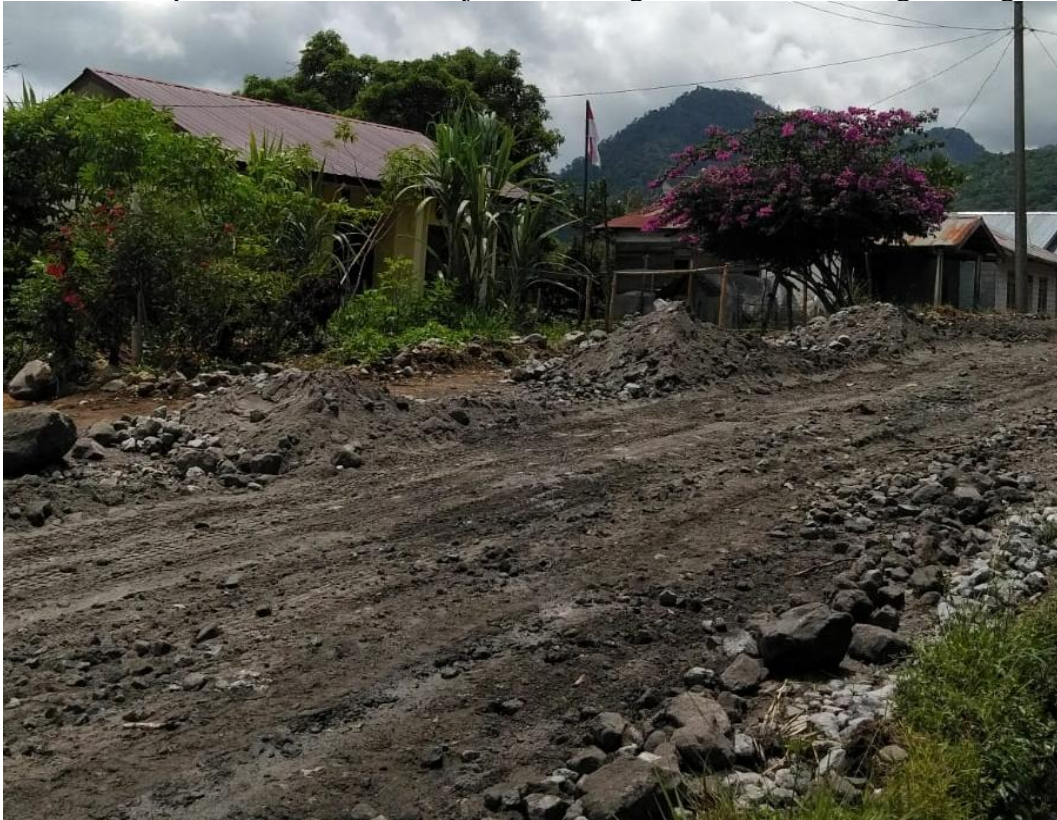
Gambar Lamp 5: Foto Lokasi Pekerjaan Pembangunan Jalan Transmigrasi Teget.
