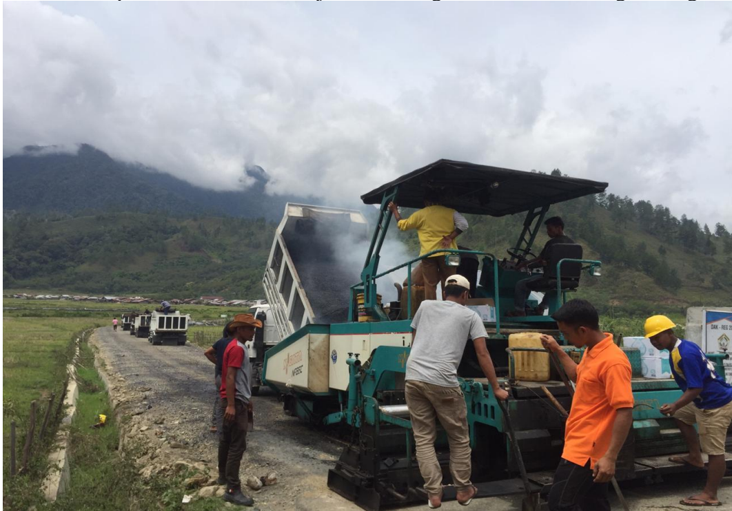
Gambar Lamp 7: Foto Lokasi Pekerjaan Pembangunan Jalan Transmigrasi Teget.
