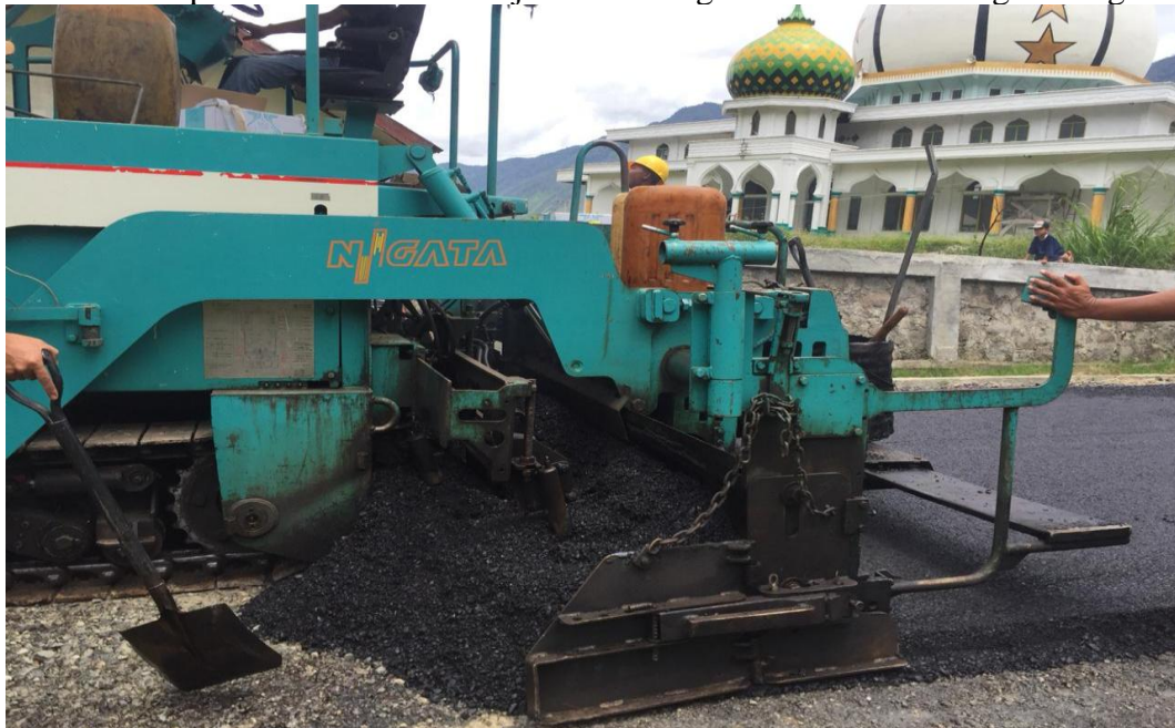
Gambar Lamp 9: Foto Lokasi Pekerjaan Pembangunan Jalan Transmigrasi Teget.
