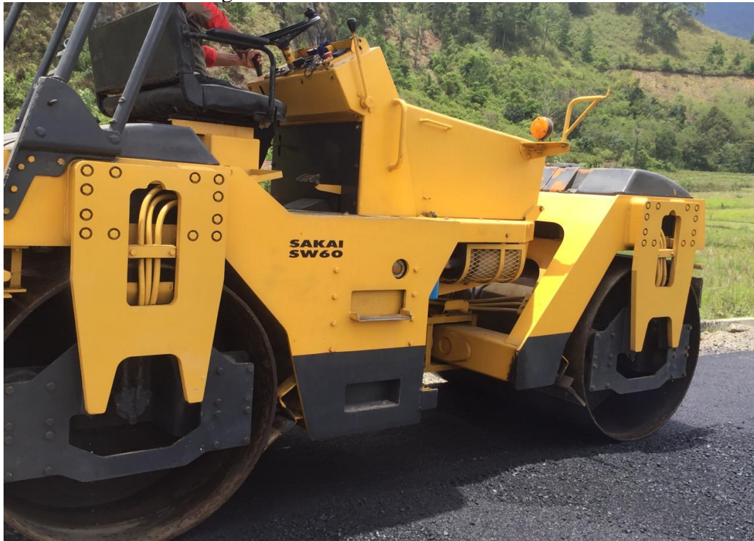
Gambar Lamp. 11: Foto Lokasi Pekerjaan Pembangunan Jalan Transmigrasi Teget.
