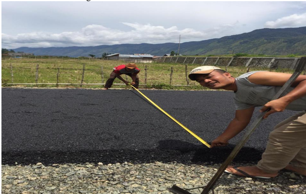
Gambar Lamp.10: Foto Lokasi Pekerjaan Pembangunan Jalan Transmigrasi Teget.
