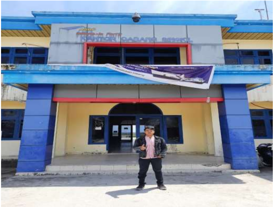
Gambar L7: Gedung Terminal Pelabuhan Aceh Singkil
