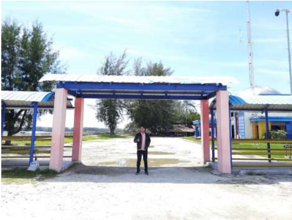
Gambar L1: Pintu Gerbang Masuk Parkiran Mobil
