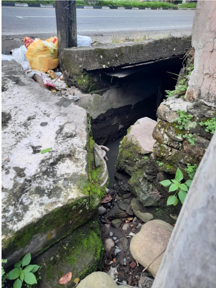
Gambar L.5: Kondisi drainase yang mengalami kerusakan penampang
