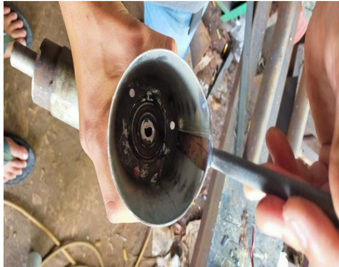
Gambar 4.7 menyambungkan tail van dengan rumah generator.
