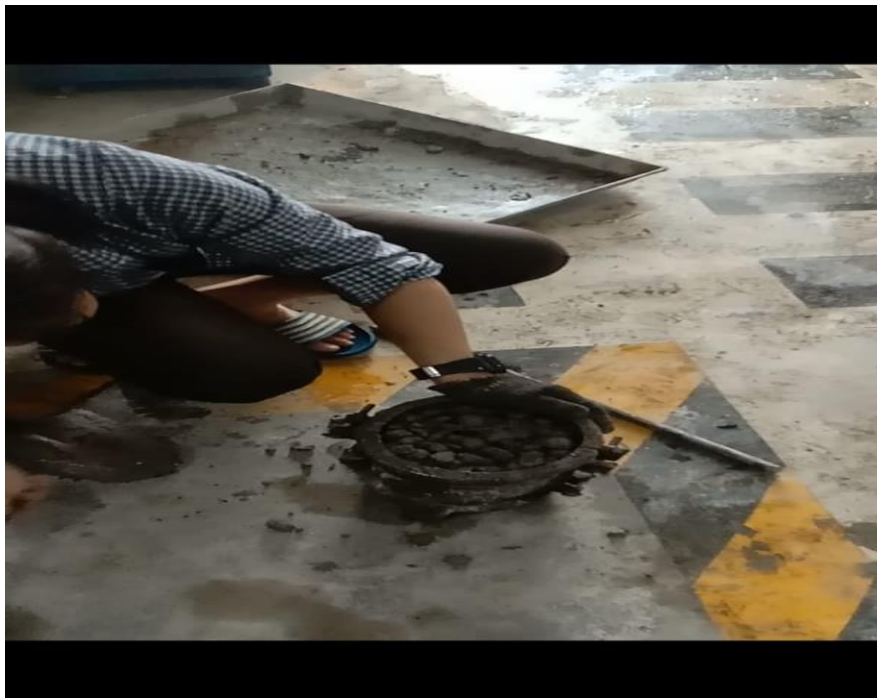
Gambar L15 : Pengisian campuran kedalam cetakan
