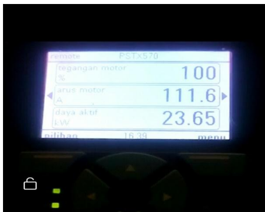
Gambar 4.5 Besaran Arus Nominal Yang Terlihat Pada Module Display&Key
