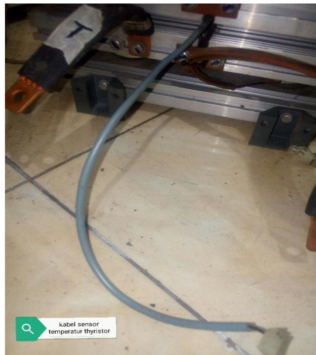
Gambar 2.16 Kabel Sensor Temperatur Thyristor Yang Terhubung Dengan Blok
