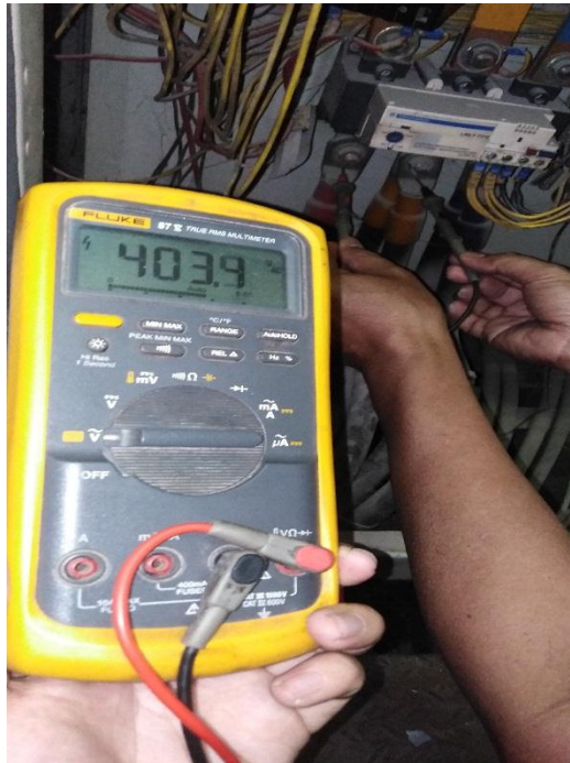
Proses Pengukuran Tegangan 3 Fase Ke Motor Yang Didampingi Oleh Pembimbing lapangan
