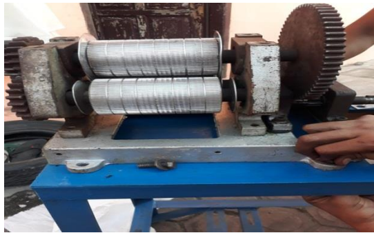
Gambar 4.23 Hasil Pemasangan Mesin Peras Tebu
