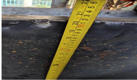
Gambar 4.2 Pengukuran Besi Siku Dan Plat Besi
