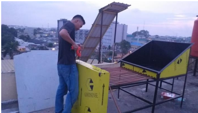
Tahap Pemasangan Penyerap Pipa Tembaga Pada Kolektor
