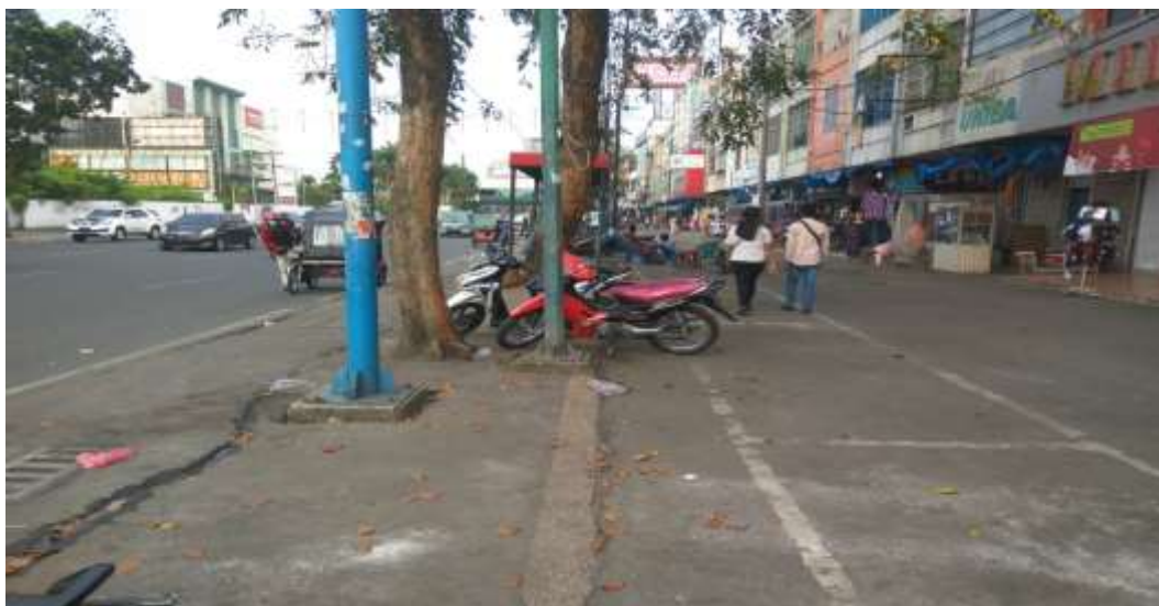
Gambar 4.7: kondisi jalur pedestrian
