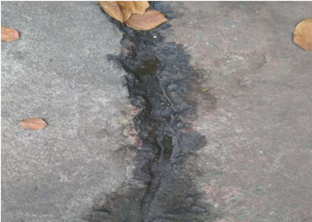
Gambar L2: Kondisi jalur pedestrian
