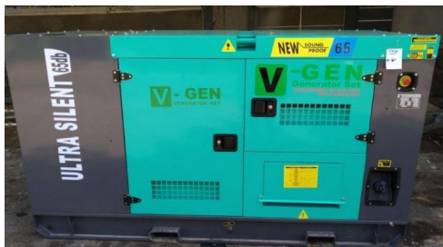
Gambar 5. Generator-Set 150 kVA
