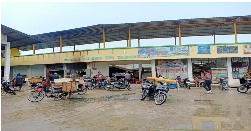
Gambar 4. Gedung Kuliner TPI Tanjung Beringin
