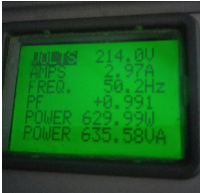
Gambar 4.2 Hasil Pengukuran Dengan beban 54 buah lampu TL Setelah Pemasangan Kapasitor Bank sebesar 6 \mu f
