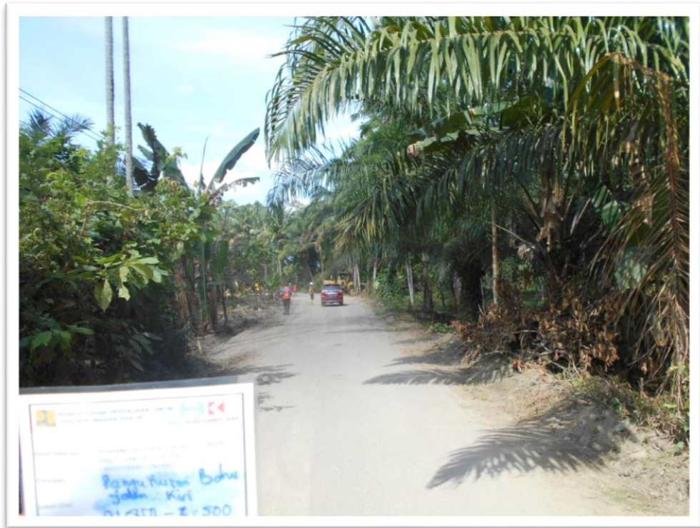
Gambar L.11: Kondisi Akses Jalan Masuk Pada Pembangunan Bendungan Lau Simeme Kecamatan Sibiru-Biru Kabupaten Deli Serdang.
