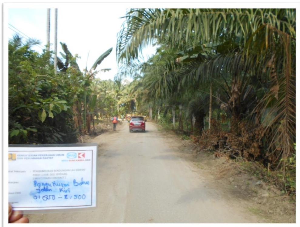
Gambar L.12: Kondisi Akses Jalan Masuk Pada Pembangunan Bendungan Lau Simeme Kecamatan Sibiru-Biru Kabupaten Deli Serdang.
