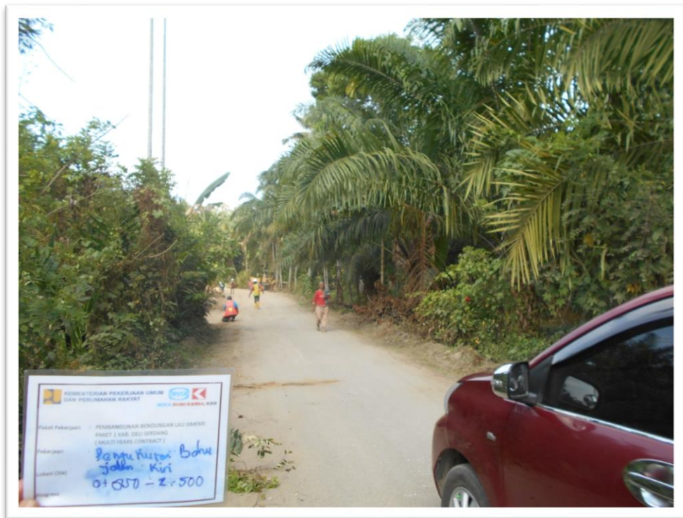
Gambar L.10: Kondisi Akses Jalan Masuk Pada Pembangunan Bendungan Lau Simeme Kecamatan Sibiru-Biru Kabupaten Deli Serdang.
