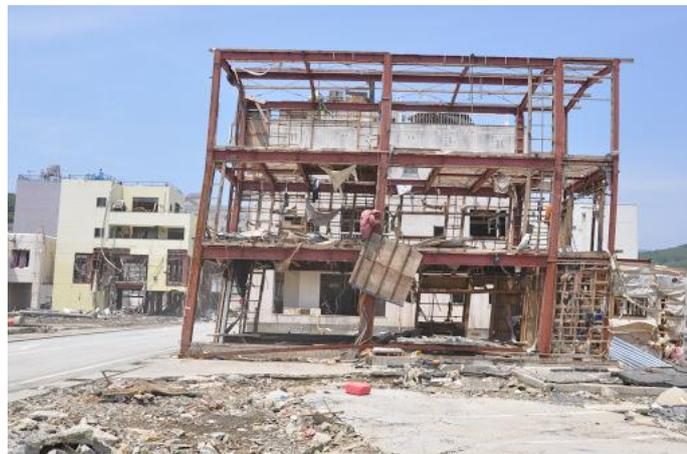
Gambar 2.15: Bangunan runtuh terkena gempa, (Tohoku Japan Earthquake,2011).
